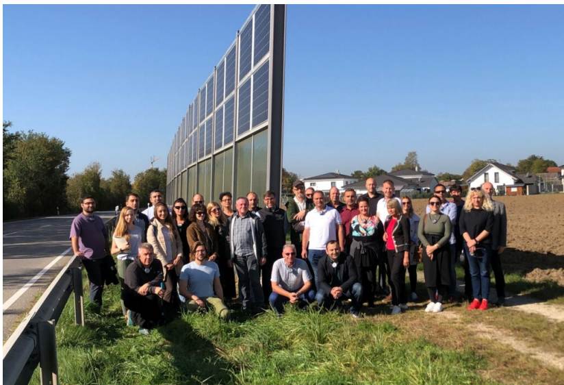
Lärmschutzwand mit Solarmodulen der EnergieGenossenschaft Inn-Salzach eG
