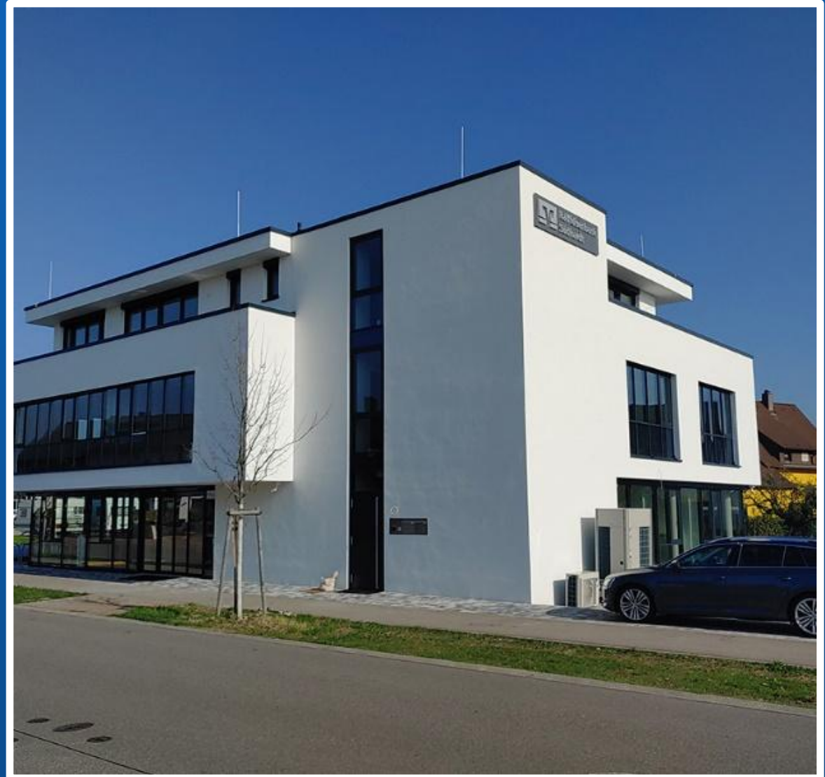
Nachhaltige Filiale der Raiffeisenbank Südhardt eG mit Solarstromanlage und E-Ladesäule
