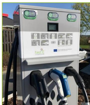
Abbildung 4: Schnellladepunkte mit CCS-Stecker (43 kW) ca. 5.000 €, Quelle: Volker Schöch, Inselwerke eG
