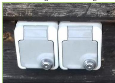
Abbildung 6: CEE/Schuco-Anschluss mit Schloss, Quelle: Inselwerke eG
