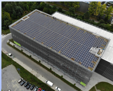
Kommunales Parkhaus Gewerbegebiet Reutlingen (316,8 kWp)
