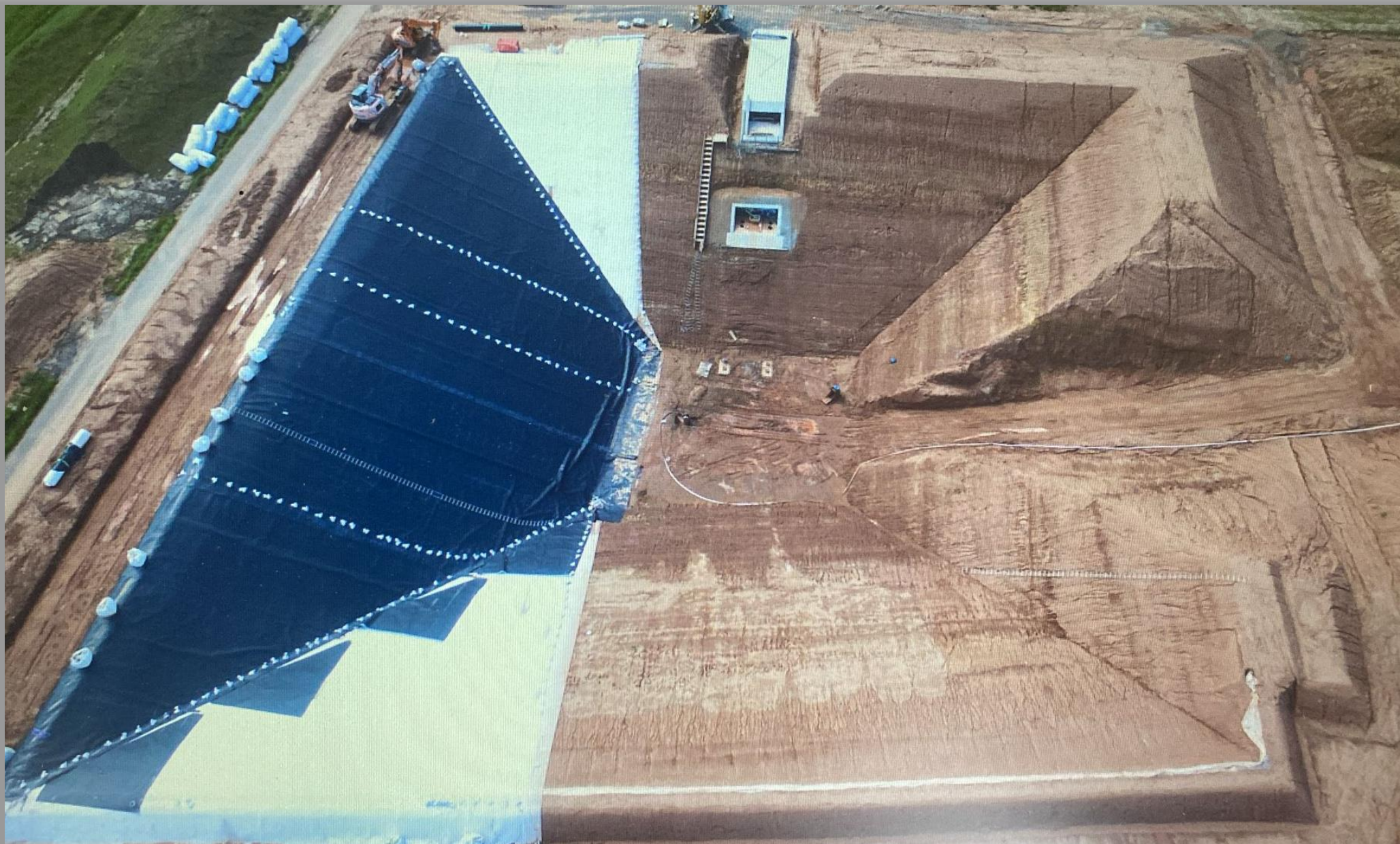
Mai 2024 – Beginn der Auskleidungsarbeiten
